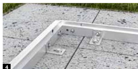
Per una piena stabilità e un montaggio sicuro delle casette da giardino e delle rastrelliere per legna da ardere Hörmann, è assolutamente necessaria una sottostruttura orizzontale. Le soluzioni per l'esterno vengono ancorate e montate su una superficie pavimentata, asfaltata o cementata di almeno le dimensioni della casetta da giardino. Se la sottostruttura non è in piano, potrebbero esserci limitazioni in termini di struttura, funzionalità e sicurezza.
